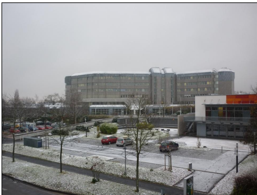
Obr. 1 Budova Spolkového archivu v Koblenzi
