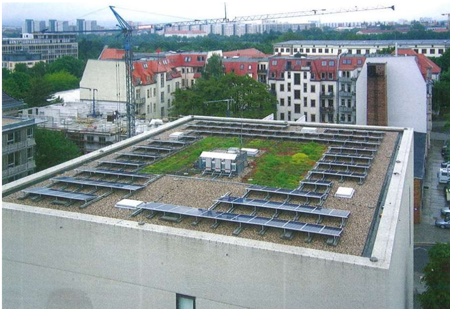
Plochá střecha nového depotního bloku – vegetace, solární panely.
