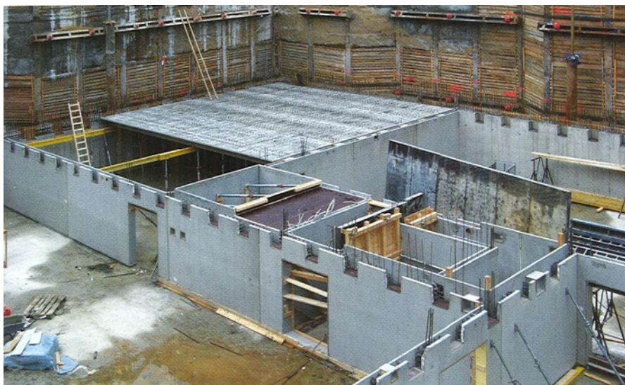
Rozestavěné 1. NP nového bloku – montáž prefabrikovaných nosných stěn a stropů
