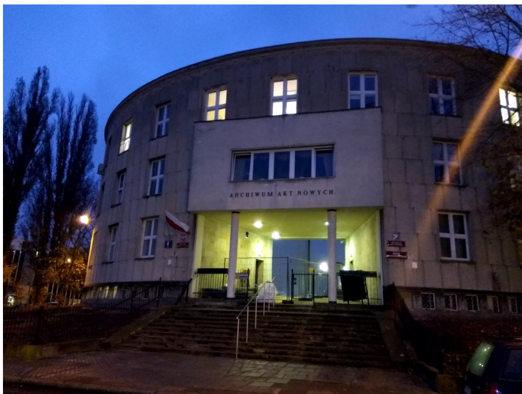
Budova archivu po příjezdu
