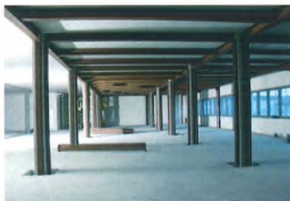
Abb. 12: Last der Geschichte: Verstärkung der Stützen unter den neuen Magazinen.
