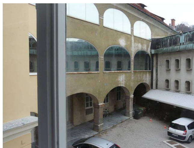
Obr. 5. Pohled na nádvoří ASR, vpravo přestavěné jihovýchodní křídlo
