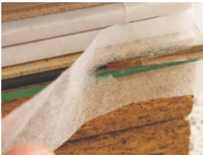
Obr. 11 Detail přilepování proužku japonského papíru
