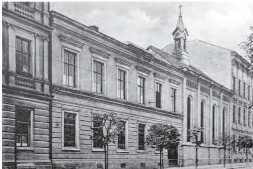
Klášter boromejek na Údolní ulici v Brně – nedatováno (Archiv Kongregace Milosrdných sester sv. Karla Boromejského, Šporkova 12, materiál k dějinám konventního domu v Brně-Údolní ulici.)
