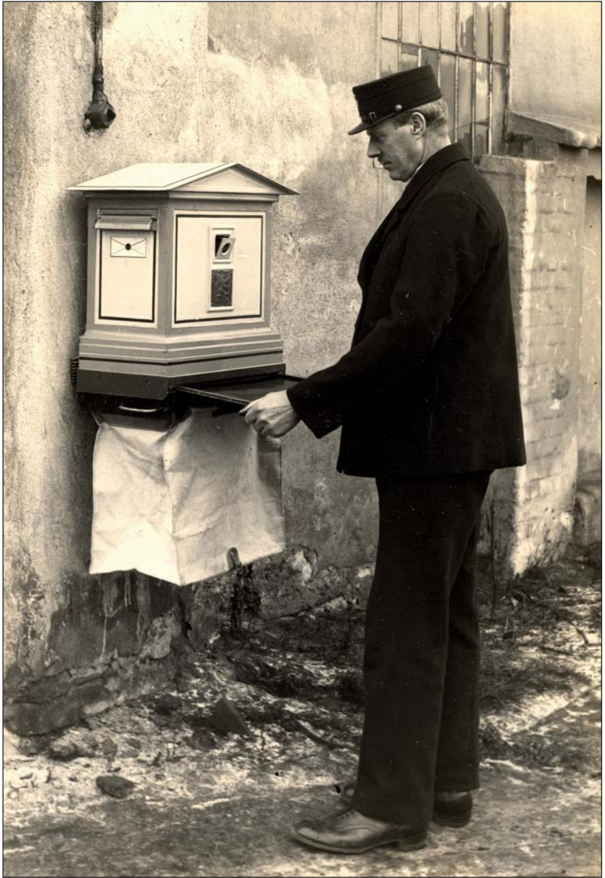
Vybirání schránky systému Paris-Krátil pomocí sběrného vaku s rámem, který výběrčí zasunul do lišt na spodku schránky, foto Josef Provazník, 23. 1. 1931.
