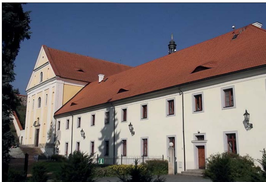
Piaristická kolej v Ostrově s kostelem Zvěstování Panny Marie (hlavní průčelí).
