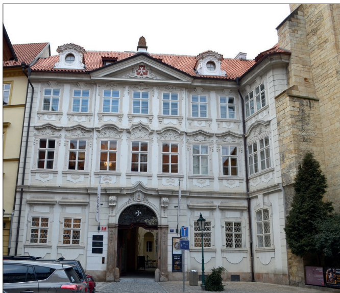
Obr. 13 Průčelí konventní budovy postavené v letech 1728–1731 podle Tomáše Haffeneckera. (foto Pavel Trnka)
