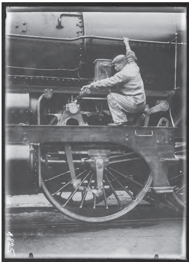
Topič maže rozvod lokomotivy řady 210 Rakouských státních drah, před rokem 1918. Národní archiv, fond Ministerstvo železnic I – fotodokumentace, inv. č. 1825, fotografická deska 13x18 cm.
